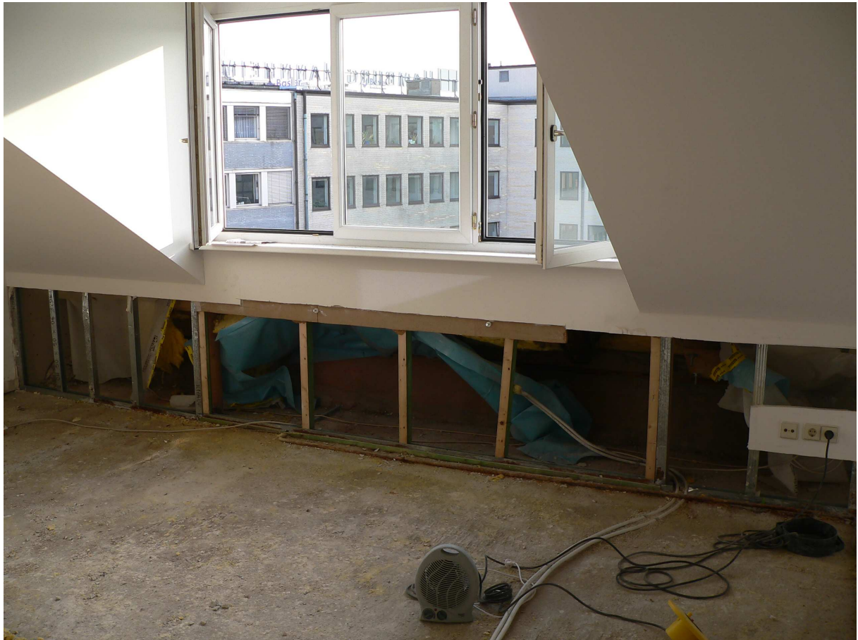
Kniestockbereich Wohnung 3 - noch ohne Fußboden-Estrich - der wird aber in den nächsten Tagen erstellt. Hier wäre der Trockenbau vor dem Fußboden günstig.
