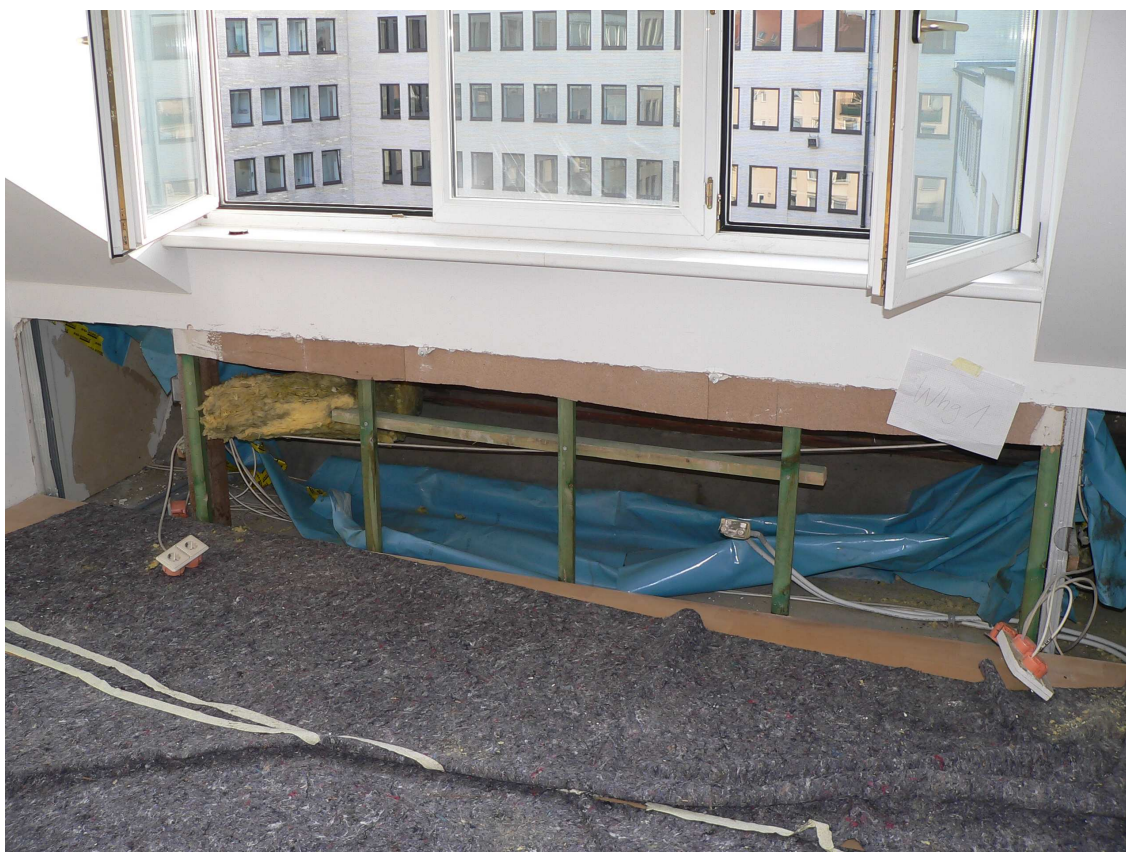
Kniestock Wohnung 1. Hier ist Fußbodenaufbau bereits vorhanden.
